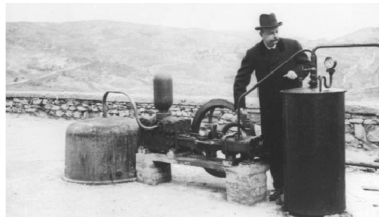
Primera instalación de generación de energía eléctrica de origen geotérmico en Larderello (Italia), en 1904
